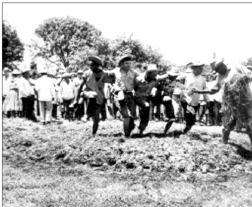
Campesinos de Azuero mezclando barro y paja para la construcción de una vivienda.
