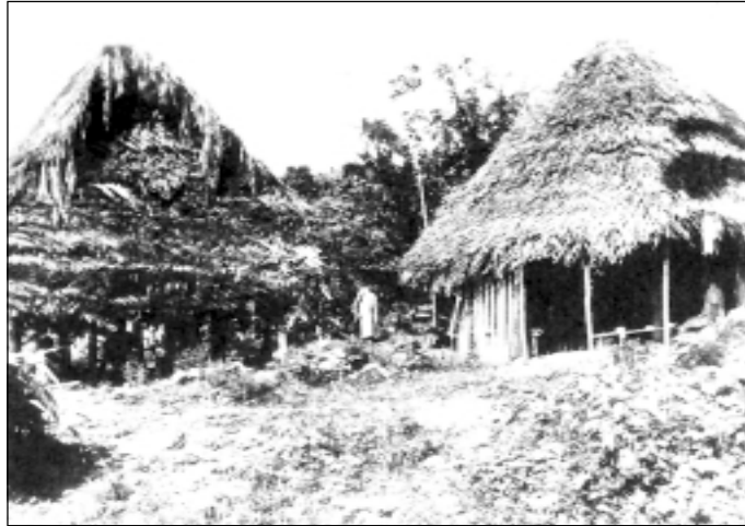
Vivienda circular construida directamente sobre el piso de tierra y casa rectangular sobre pilotes bajos. Río Luis, Bocas del Toro.
