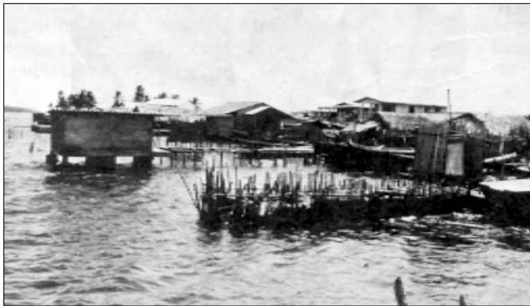
Rincón de una isla de San Blas donde pueden apreciarse construcciones de bloques y techo de zinc, tanto en vivienda como en servicios higiénicos.
